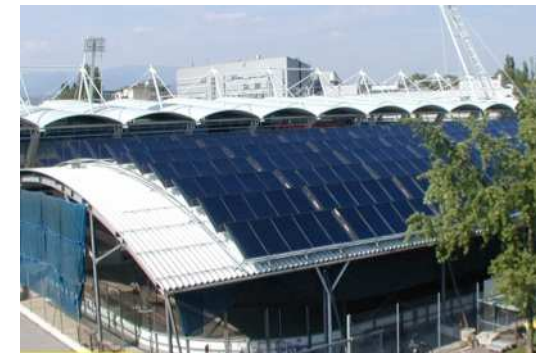
Postrojenje na stadionu Liebenau, Graz (AT)
