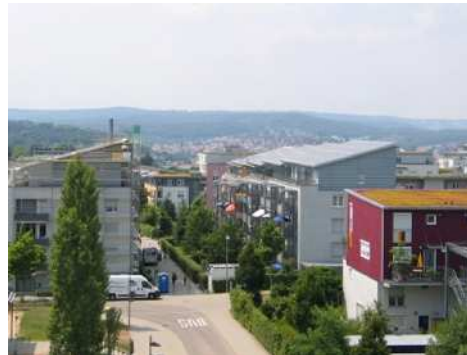
Postrojenje u Stuttgart Burgholzhof (DE)
